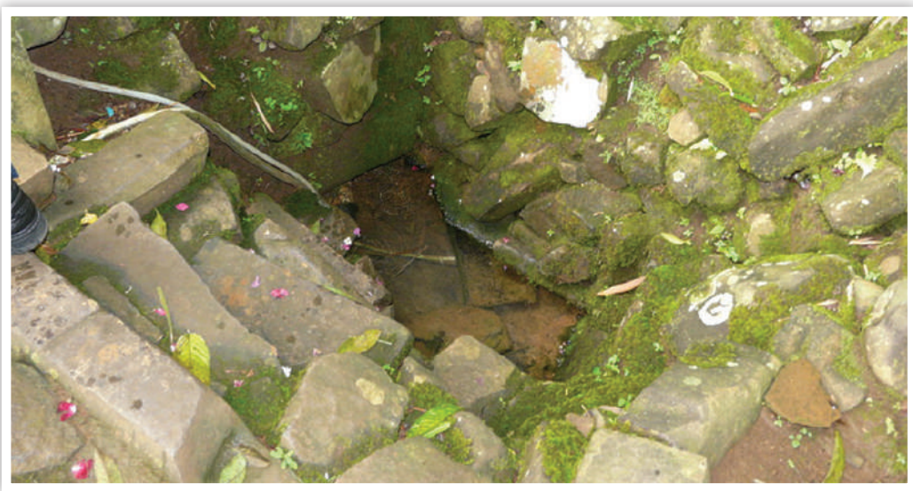
Foto 3.4 Sumur (mata air) pola susun balok batu pertama yang terdapat di kaki sebelah utara situs Gunung Padang. (Yondri, dkk., 2012)
